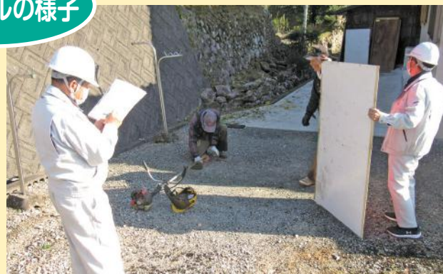
機械の点検、防護板の適切な設置ができているか
