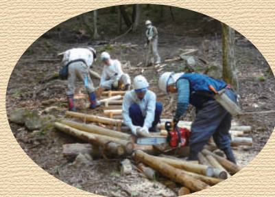
遊歩道整備作業
