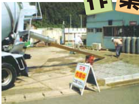
▲土間コン打ち
