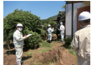
高所作業時の安全対策確認
