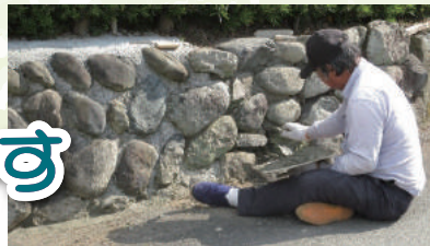
石垣セメント詰め
