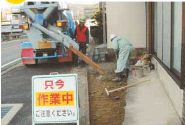
工事作業【波賀事業所】
