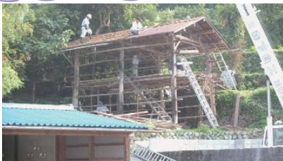
稲木小屋の解体
