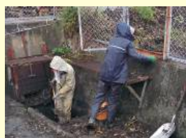
雨水溜り泥上げ
